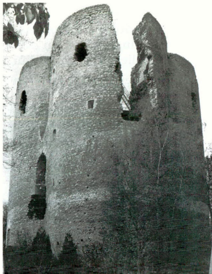
Figure 12. La tour vue du sud-est (rapprochée). A gauche, la porte et son pan coupé, au centre, la demi-tour sud-est avec la grande brèche éventrant le palier haut de l'escalier rampant et les locaux muraux du 2 e étage (état en 1982).
