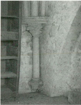
Figure 16. Étampes, Notre-Dame, colonnette à la retombée nord-ouest des ogives de la salle supérieure.
