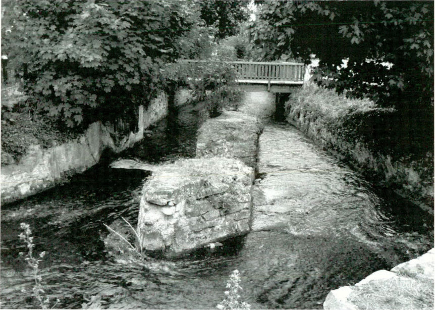
Figure 7. Ruines du Moulin Notre-Dame (état septembre 2009).
