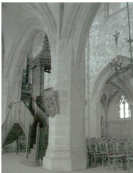
Figure 3. Étampes, Saint-Basile, pile du vaisseau central.
