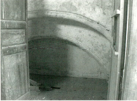
Figure 14. Étampes, Notre-Dame, vue du collage des maçonneries dans l'angle sud-ouest de la salle supérieure.
