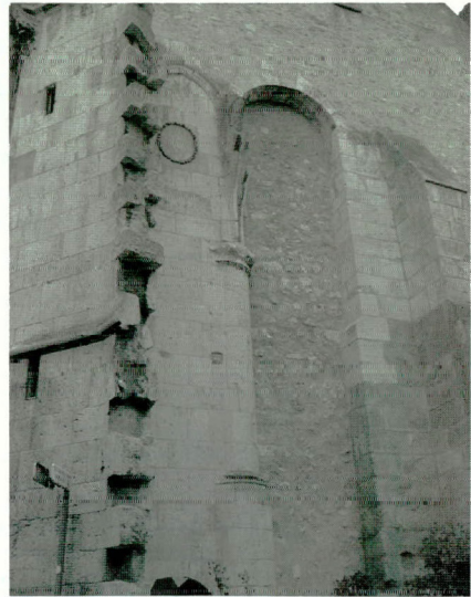
Figure 21. Étampes, Saint-Basile, flanc sud du chevet.
