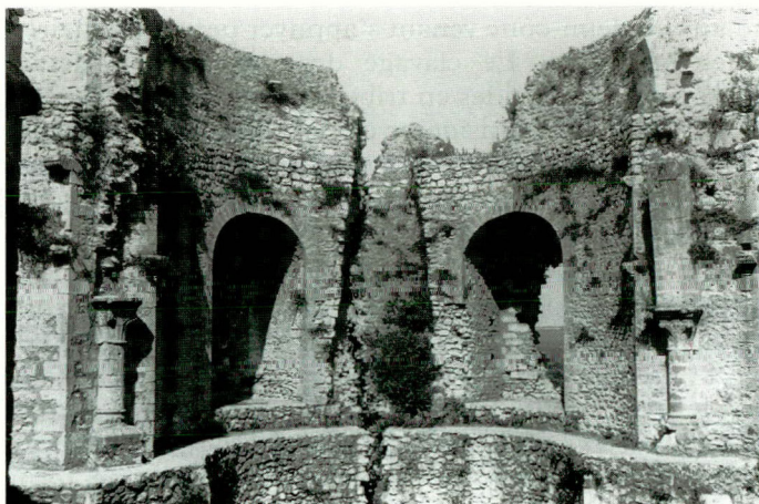
Figure 10. L'abside nord-est au 2 e étage (et tribune), encadrée des colonnes à chapiteaux de la salle, portant les départs des arcs diaphragme croisés. (état en 1979).
