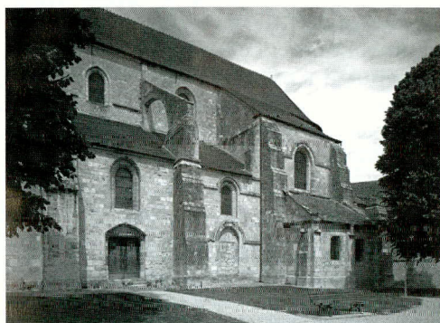
Figure 14. Étampes, Saint-Martin, flanc sud de la nef.
