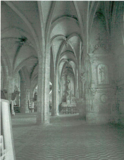
Figure 12. Étampes, Saint-Basile, bas-côtés extérieurs sud de la nef et chapelles latérales.
