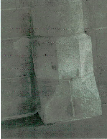
Figure 6. Étampes, Saint-Basile, bases des colonnettes engagées des chapelles latérales.
