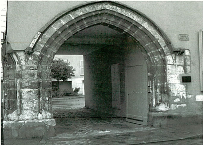
Figure 1. Porte en arc-brisé rue Saint-Antoine, à droite du tribunal actuel.
