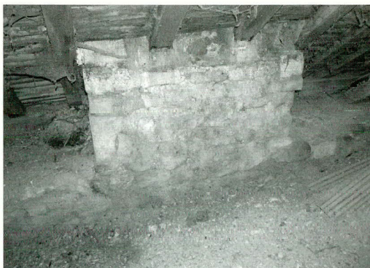
Figure 19. Étampes, Saint-Martin, souche de la culée prise sous le toit.
